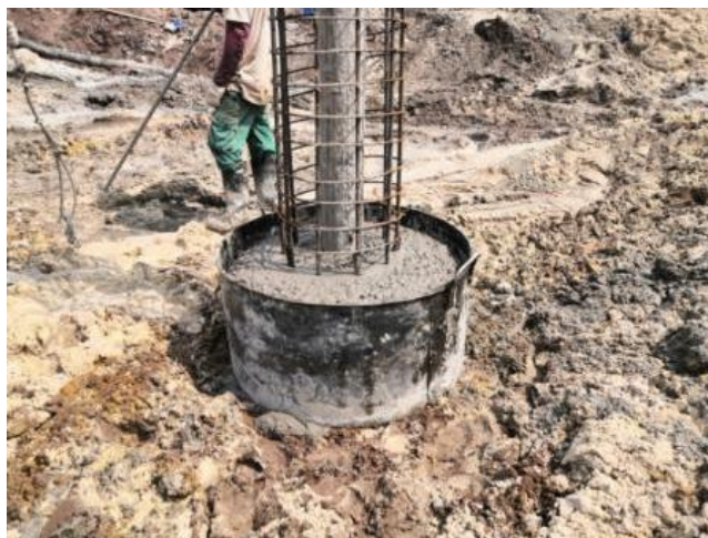
图3.2 混凝土收容器使用后
