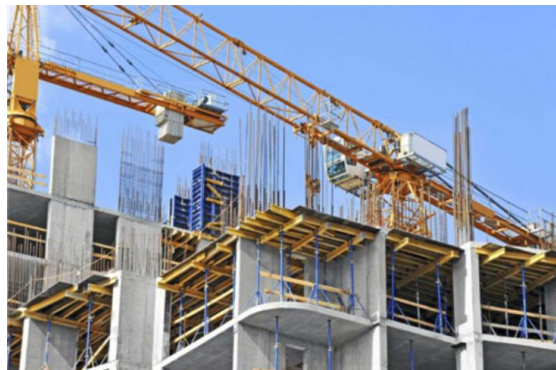
图3 装配式建筑施工高效环保
