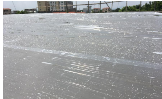
图1 混凝土保温膜
