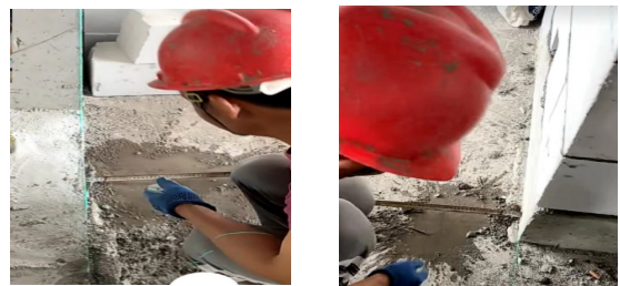
图2：砌体底部红外控制线引线操作
