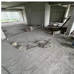
图1：现场施工定位方放线图
