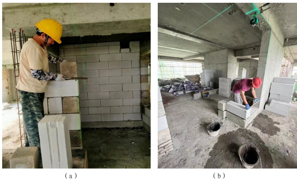
图4: 利用红外线激光线对门洞口砌筑图
