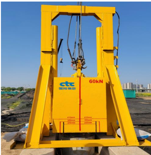
图2 锤击现场施工图
