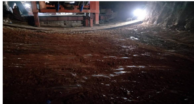
如图4-3-1 仰拱开挖现场图
