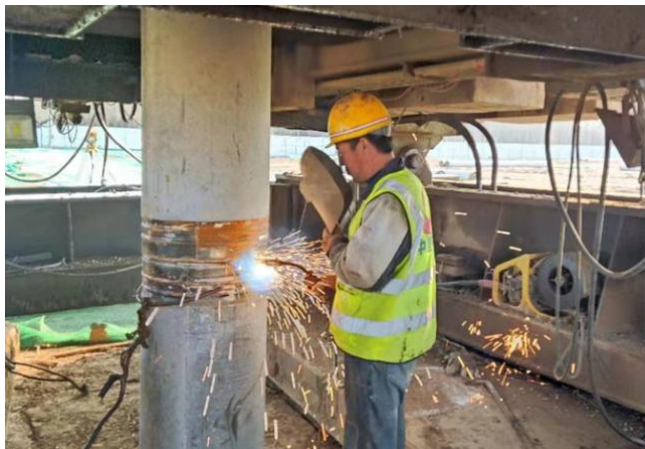
图一 接桩部位的焊接
