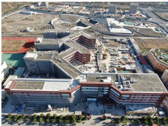
图1 现场施工图片自己拍摄
