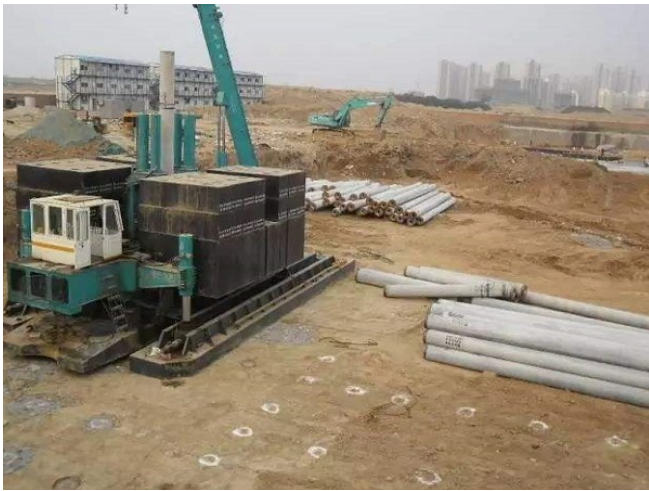
图1 静力桩压桩施工
