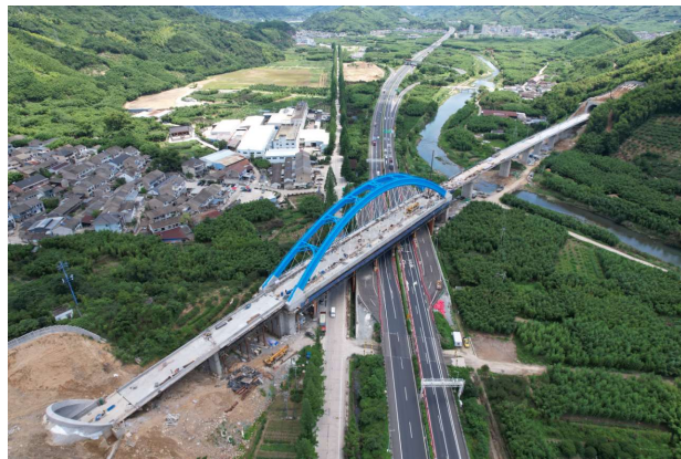
图1 系杆拱周边环境航拍图
