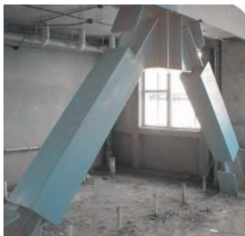
图1 屈曲约束钢支撑体系构造
