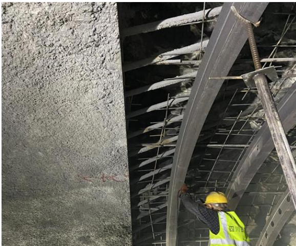
图5 超前导管施工
