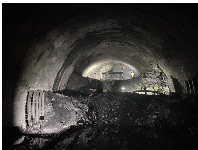
图3 三台阶施工工法进行开挖
