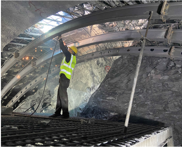
图4 超前导管钻孔施工
