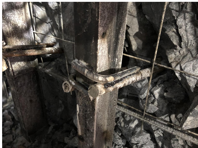
图2 锁脚锚管施工
