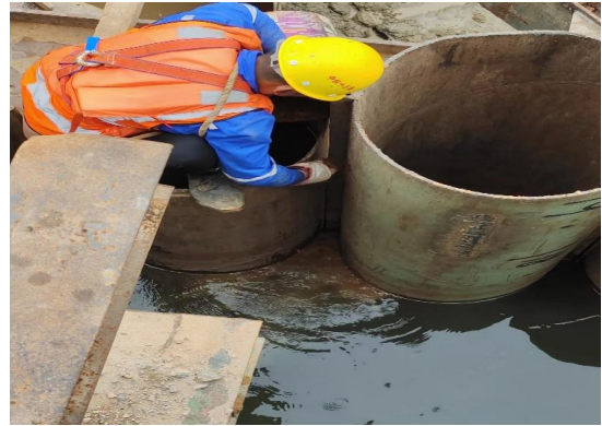
图 8 围堰止水
