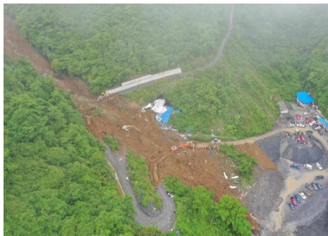
图2 金口河鹿儿坪滑坡发生后现场图
