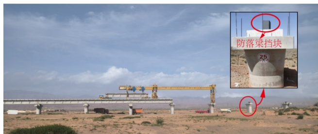
图 4 墩顶防落梁挡块
