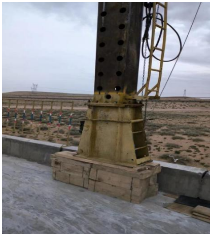
图7 改造后的3#柱垫脚
