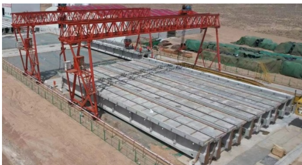
图1 银巴铁路预制T梁
