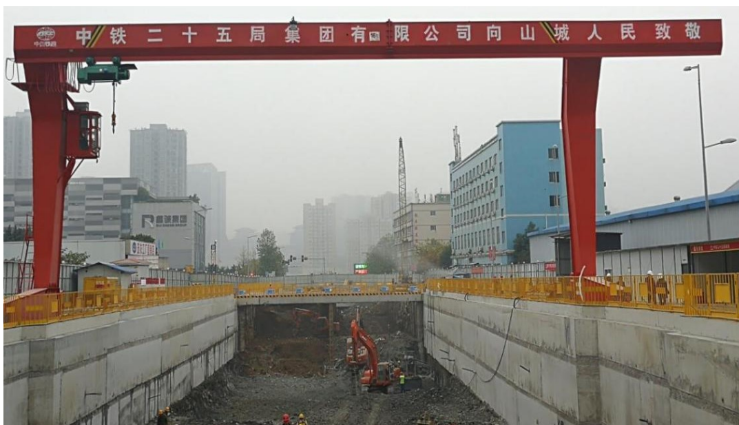
图一：春华大道车站板肋挡墙逆作法施工
