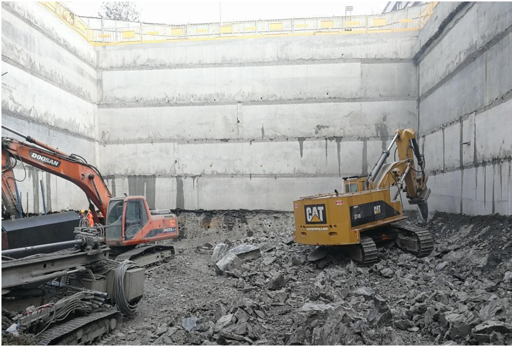
图二：春华大道车站板肋挡墙逆作法施工
