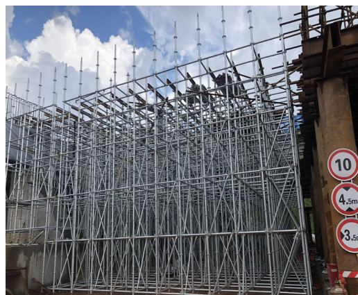
图5 立杆横纵向间距由原来的60×60cm变成了90×90cm，承载能力强
