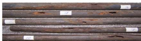
(c) 重度腐蚀
