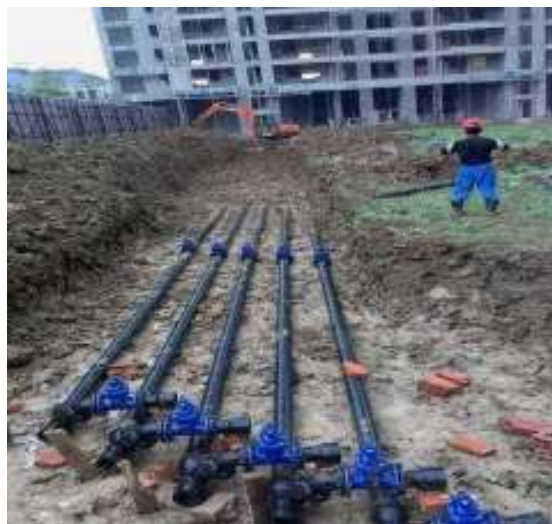
图一 市政给水排水管道施工
