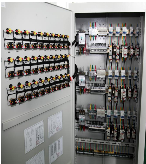
图1 高压柜二次接线图
