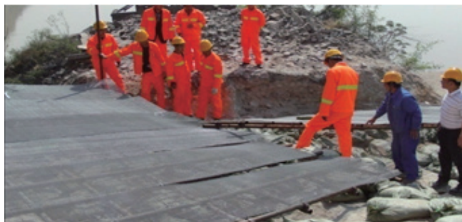
图4 基坑地面防护图
