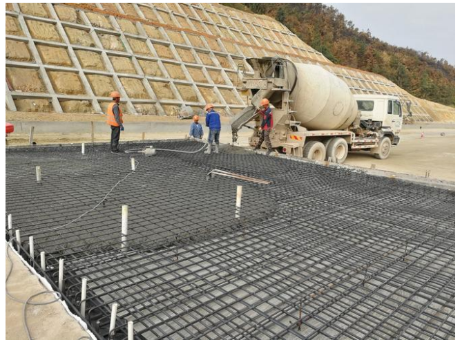
图3 桥台搭板施工
