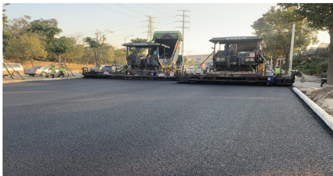
图1 橡胶改性沥青路面摊铺现场施工图
