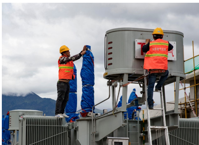
图一：变压器的安装
