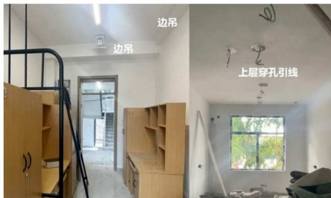
图6 线路走边吊及裸顶层穿孔引线
