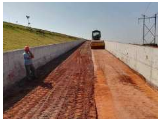
图一 路基施工
