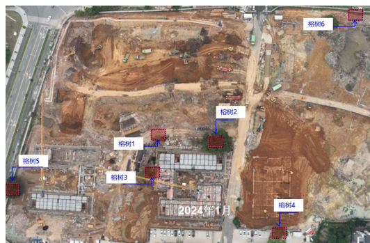
图6 施工期间保留榕树（古树名木）
