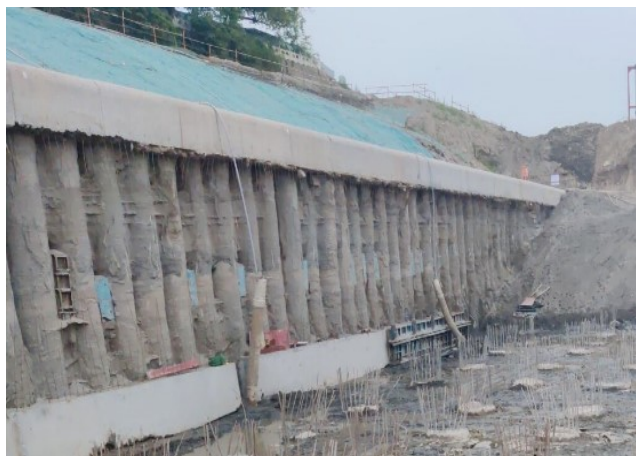
图3 双排桩支护现场实拍图
