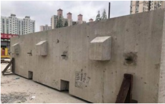
图 6 预制外墙板构件
