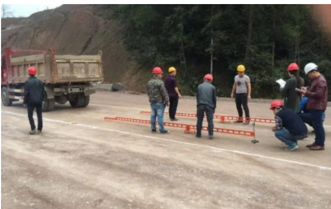
图 1: 公路工程路基试验检测技术验收
