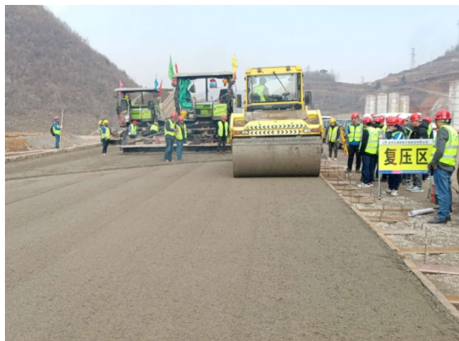
图3 水泥碎石稳定基层碾压
