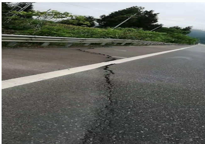
图 4 路面开裂案例图
