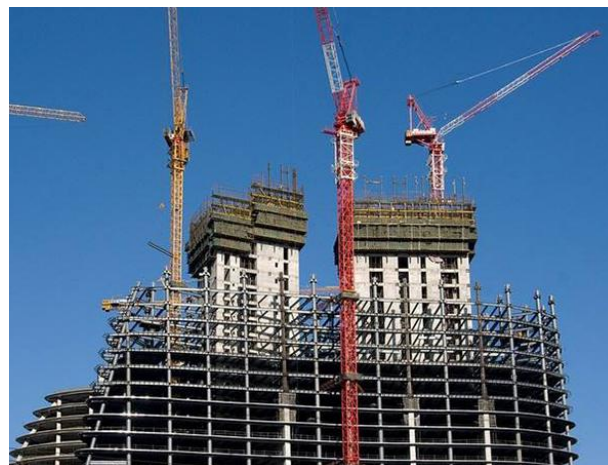
图1：房屋建筑工程施工
