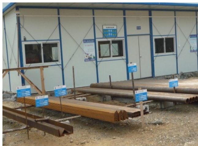
图1 施工材料监理
