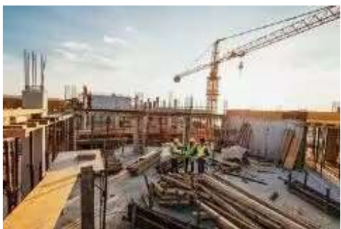
图一 建筑施工设备
