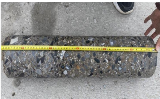
图3 三层连铺芯样实景图
