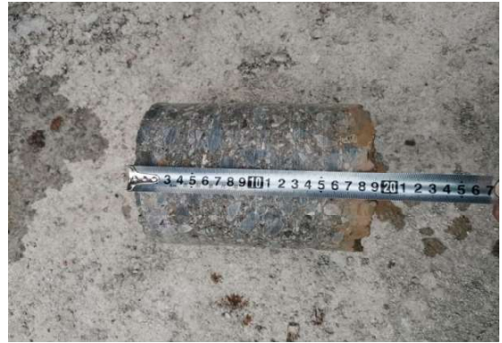
图4 分层摊铺芯样实景图
