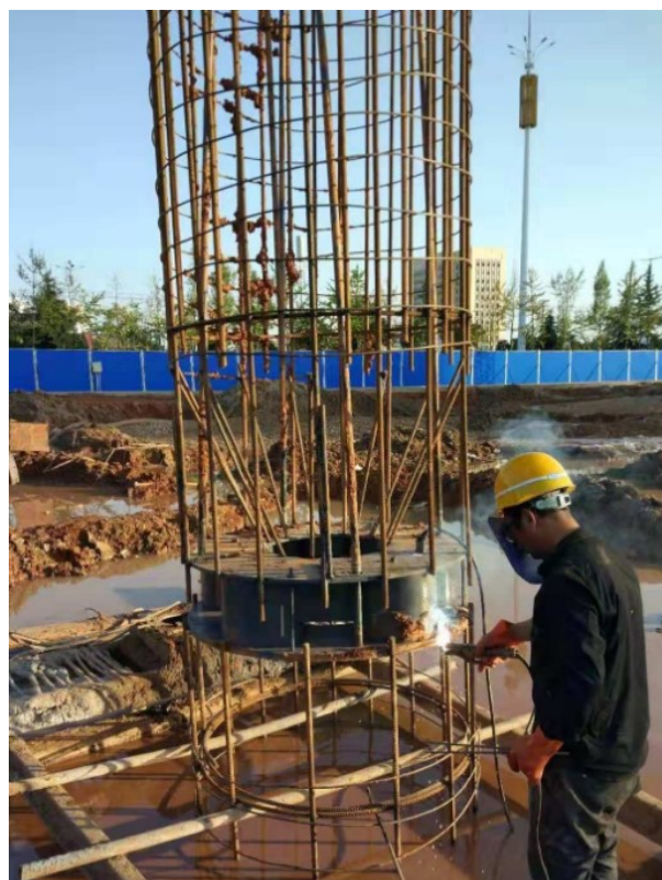
图一：自平衡静载试验安装作业现场
