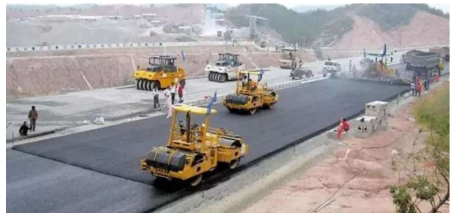
图 1 沥青公路碾压现场
