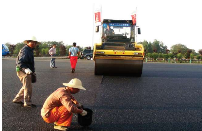
图2 沥青公路施工接缝处理
