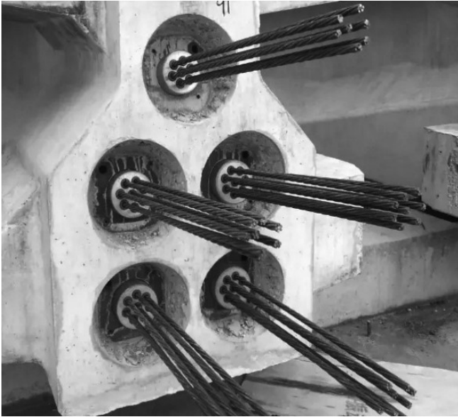
图1 预应力钢绞线施工图
