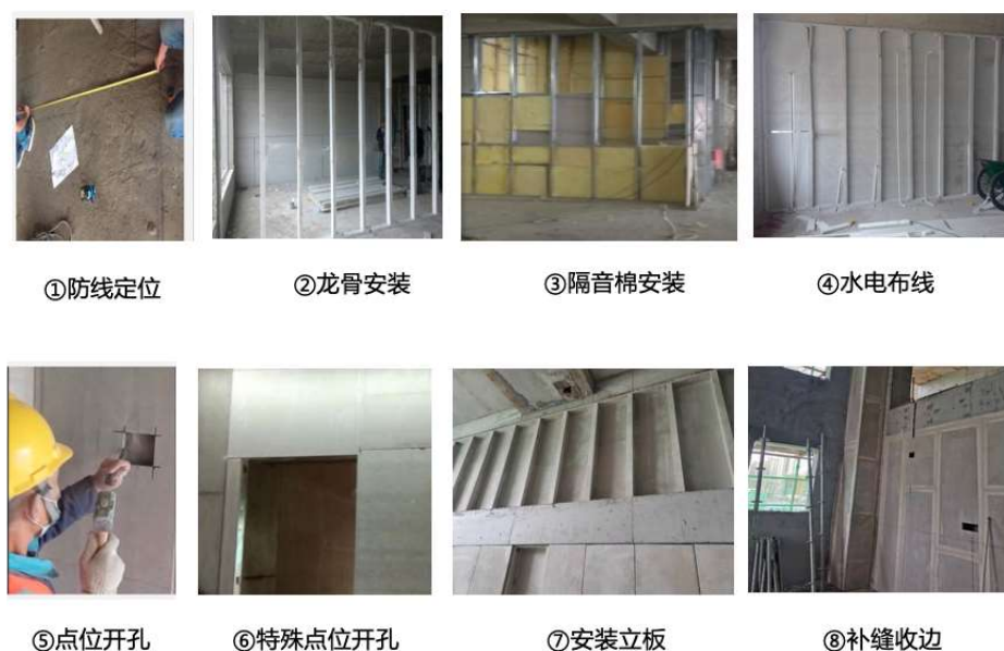
图 4. 兼强板施工步骤
