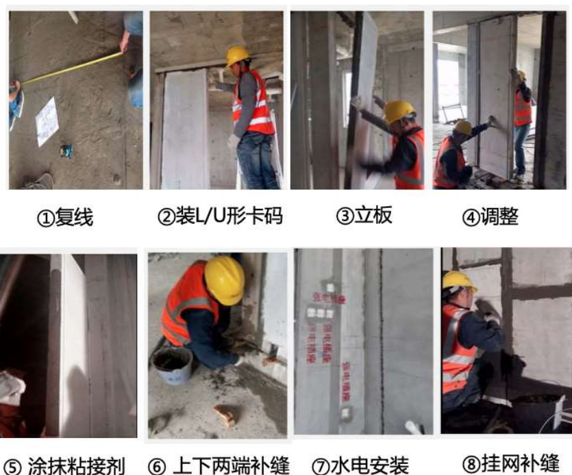
图 3. ALC 板施工步骤
