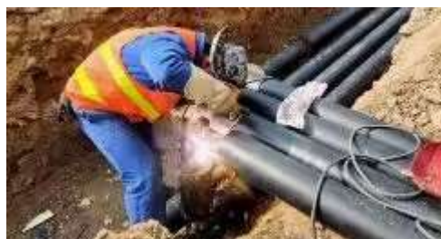
图一 管网现场安装
