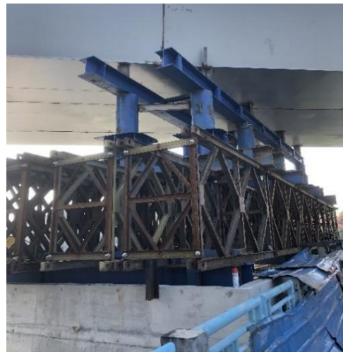
图 5.2 钢箱梁支撑架的施工图
