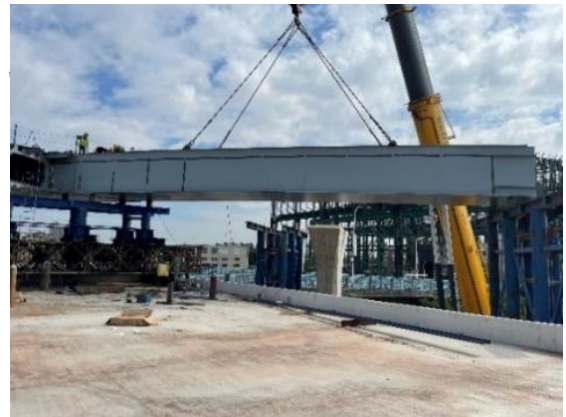
图 6.4 双台汽车吊现场吊装图
