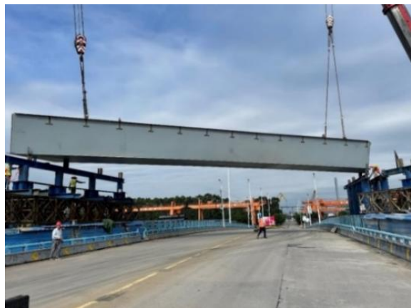
图 6.6 双台汽车吊现场吊装图
