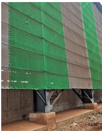
悬臂柱式支护结构图
