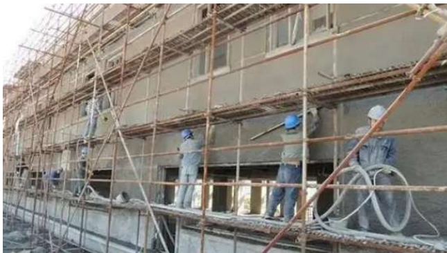
图2 外墙抹灰施工技术现场图
