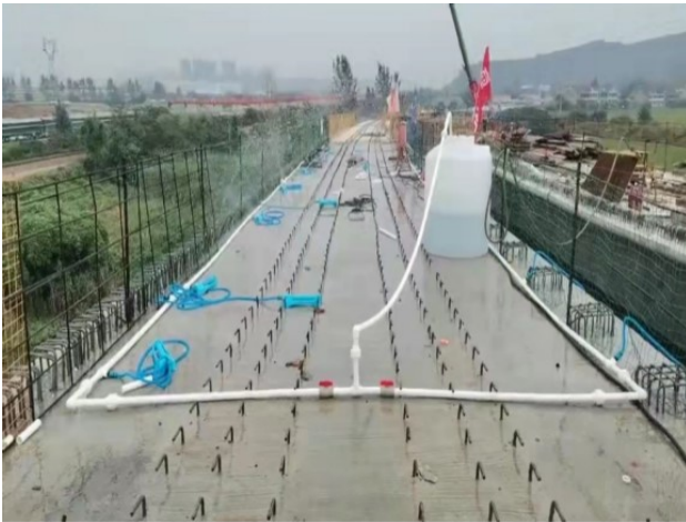
现浇梁喷淋养护
