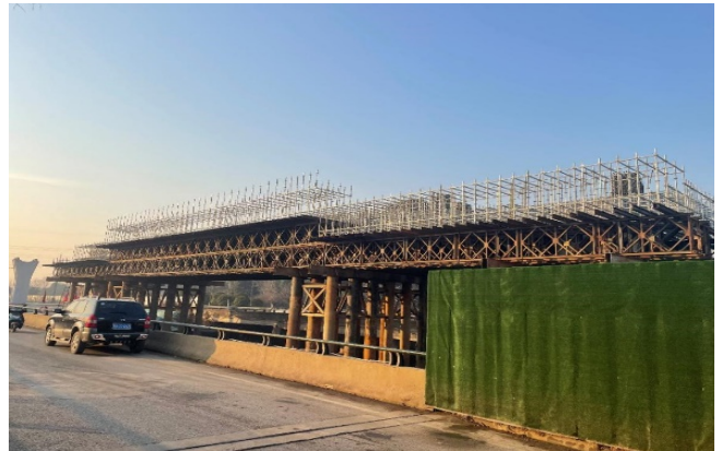
跨河道连续梁支架
