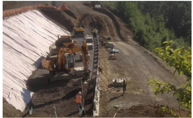
图3 第一排安装完成效果图
