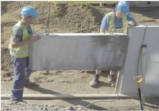
图2 第一块面板安装
