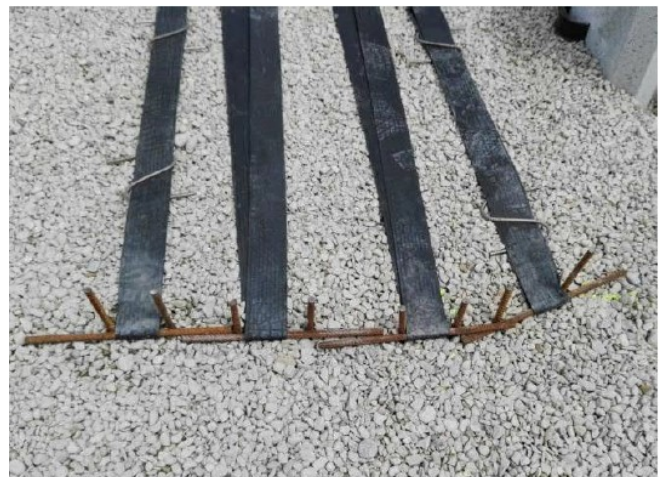
图4 加筋带安装
