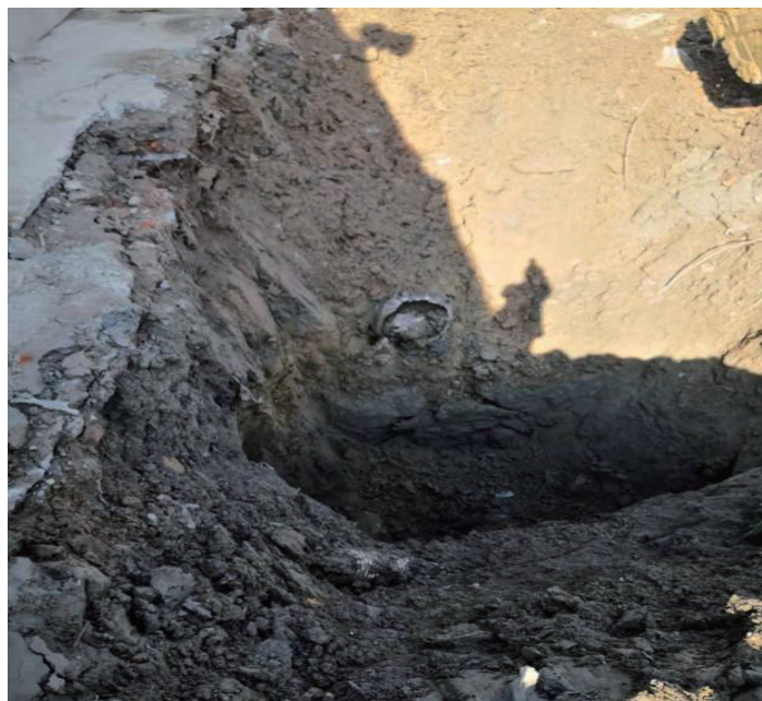
11月26日发现的管道
