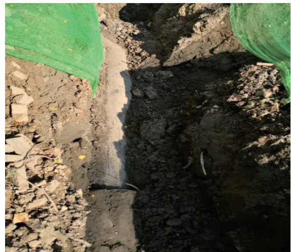
11月14日发现的管道
