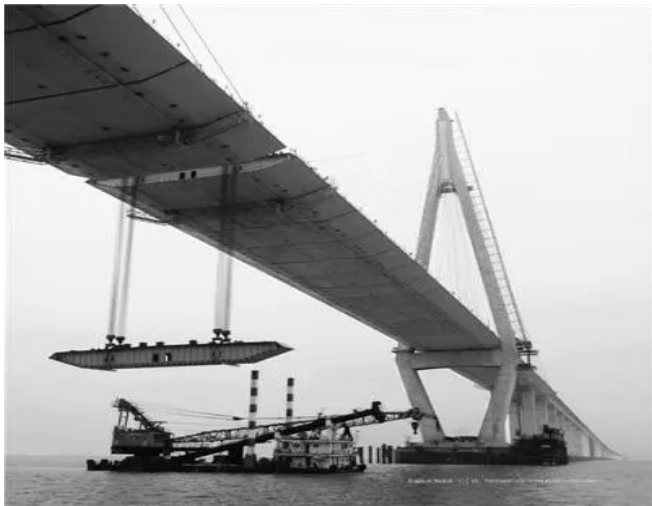
图一：正在架设钢箱梁的杭州湾跨海大桥
