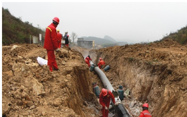
图1 为天然气管道施工安全管理现场
