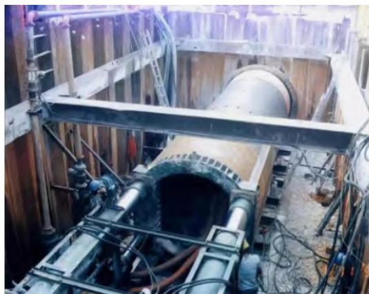
图1 长距离推管技术现场施工图
